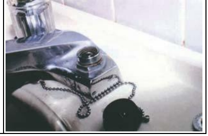
3-3 Çok ayarlı vana kapağı. Su tarafındaki kazantaşlarının giderilmesi kolaylaştı.
