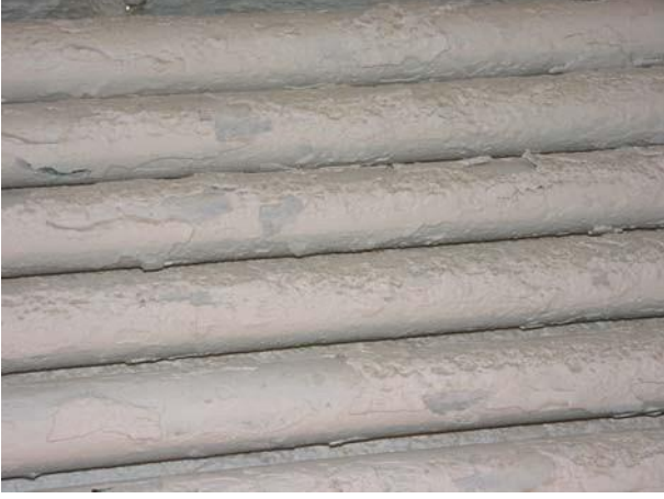
Alev borularının yüzeyine tutunmuş açık gri renkte, yumuşak kazantaşı tabakası
